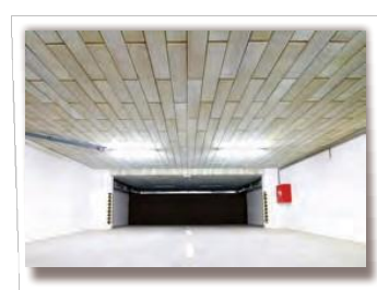
Dämmung an der Unterseite der Decken
